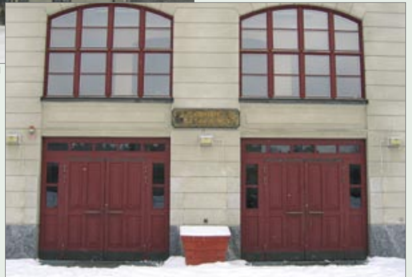
Värnpliktsingången på kasern 3, här har många kustjägare vandrat in och ut.
